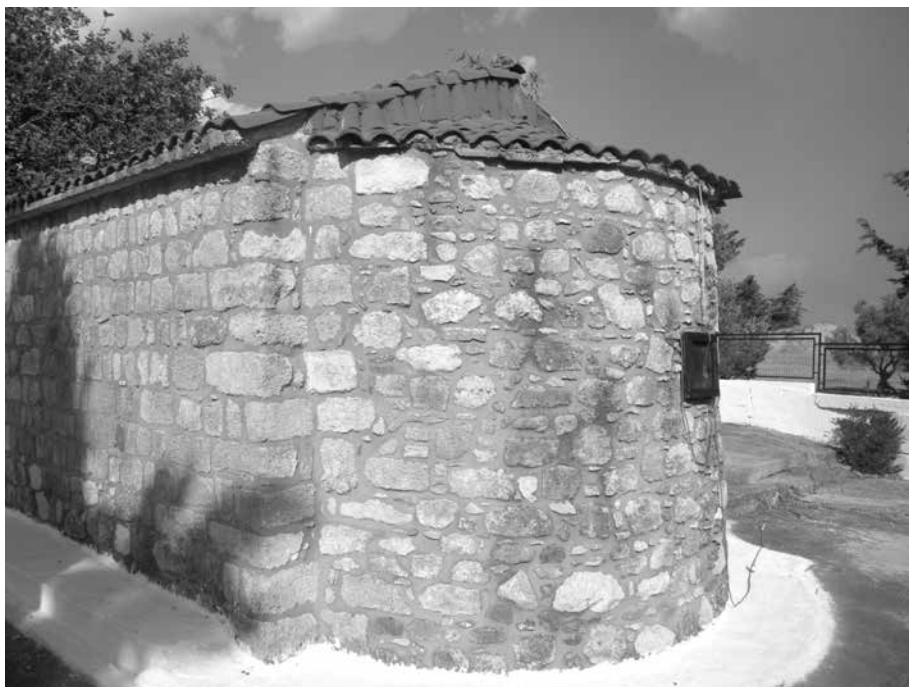
Εικ. 5. Άποψη του ναού από νοτιοανατολικά.
